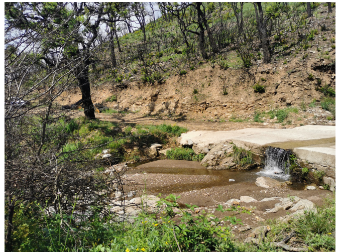
Atterrissement formés de colluvions en fond de vallon, suite à l'érosion des sols sur les versants incendiés. Ce transit sédimentaire peut engendrer en aval une aggravation de l'aléa inondation par débordement des cours d'eau; Vallon de Basset - La Garde Freinet, 2022 ©Safran
